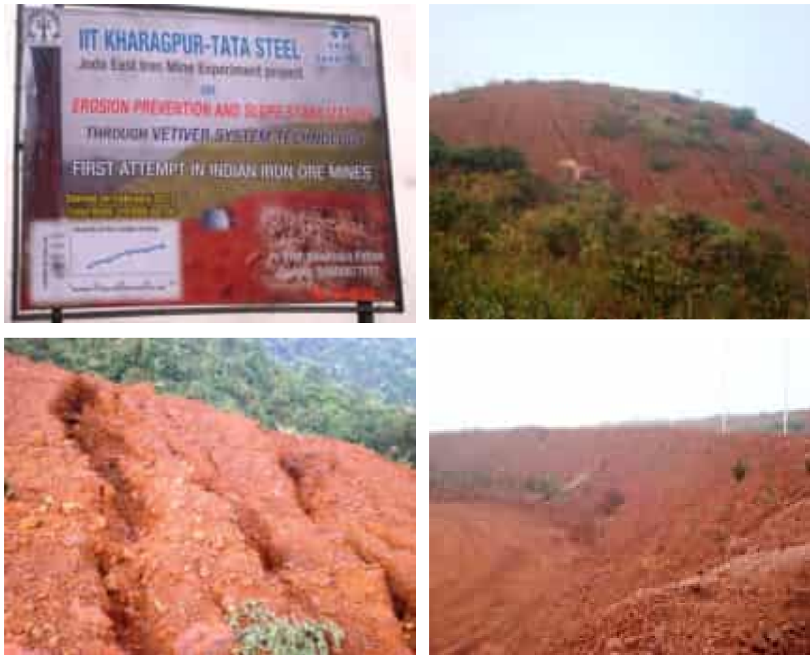
Figura 76. El vertedero antiguo es altamente erosionable y empinado (arriba e imagen izquierda inferior) y se reconfigura para que tenga una pendiente de 40° (inferior derecha)
