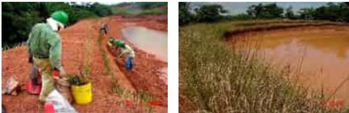
Figura 65. El Vetiver sembrado para el reforzamiento de los muros de contención de la laguna (izquierda) y 14 meses después de su siembra (derecha). Fuente: Luque et al., 2006
