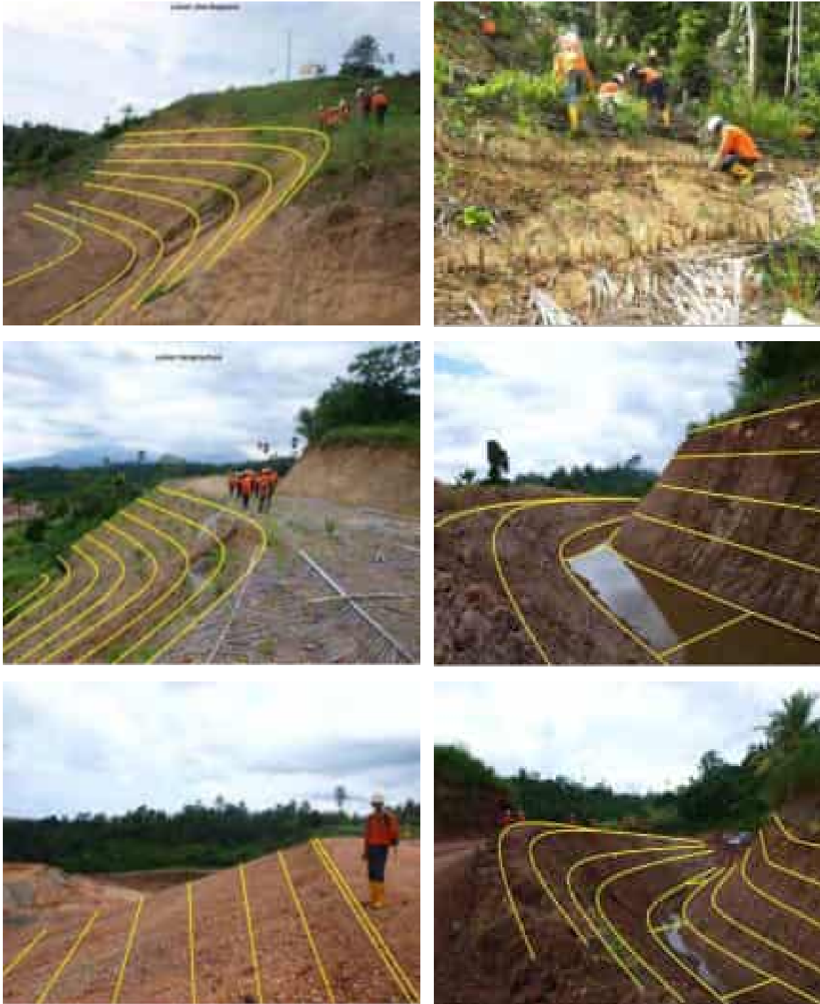
Figura 48. Diseño y aplicación de la tecnología del pasto Vetiver a lo largo de la extensiva infraestructura y del sistema de drenaje. Fuente: www.vetiver.org .
