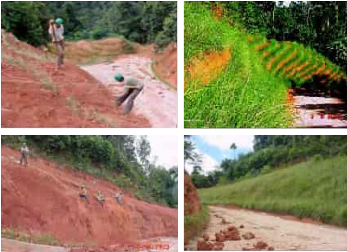
Figura 63. Varias pendientes (izquierda) estabilizadas por Vetiver (derecha). Fuente: Luque et al., 2006.
