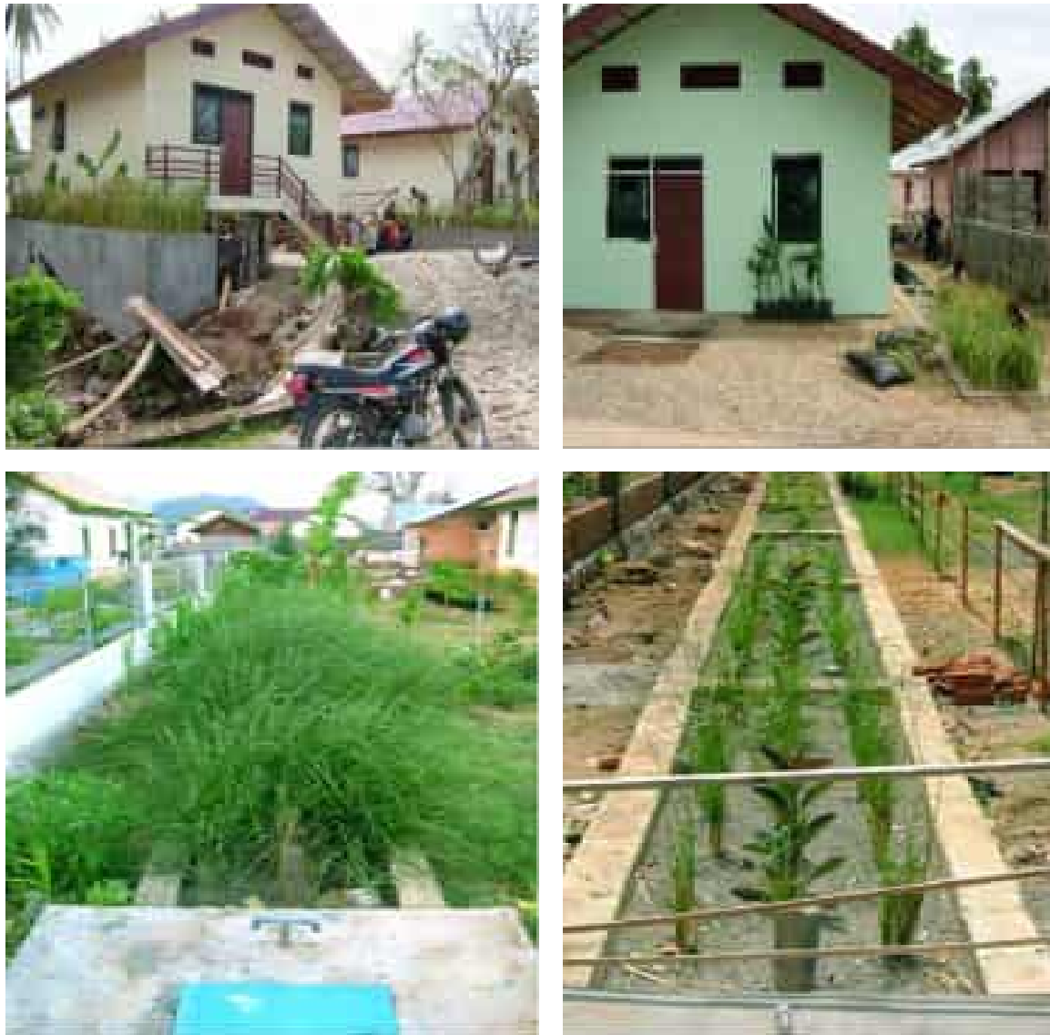
Figura 16. Sistema Vetiver para el tratamiento de drenaje doméstico, Indonesia.
