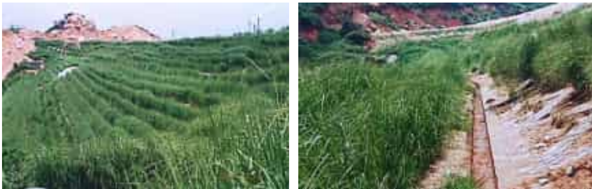
Figura 41. Plantación de Vetiver en la ladera de este relleno sanitario viejo en Guangzhou (izquierda), la filtración de lixiviado se detuvo completamente un año después de su siembra (derecha).
