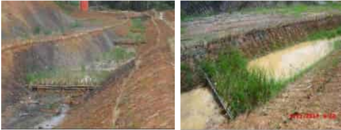
Figura 59. El vetiver se sembró para la estabilización de las laderas de las zanjas tanto a lo largo como a lo ancho del canal. Fuente: www.vetiver.org
